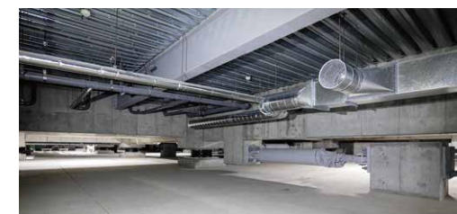
（写真1）免震ピット階 免震層
